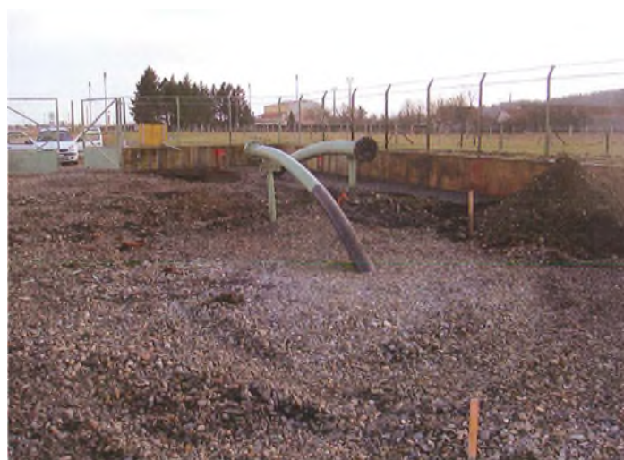
Figure 3 : Vues du site de l'ancienne gare racleur de Lendresse après démantèlement
