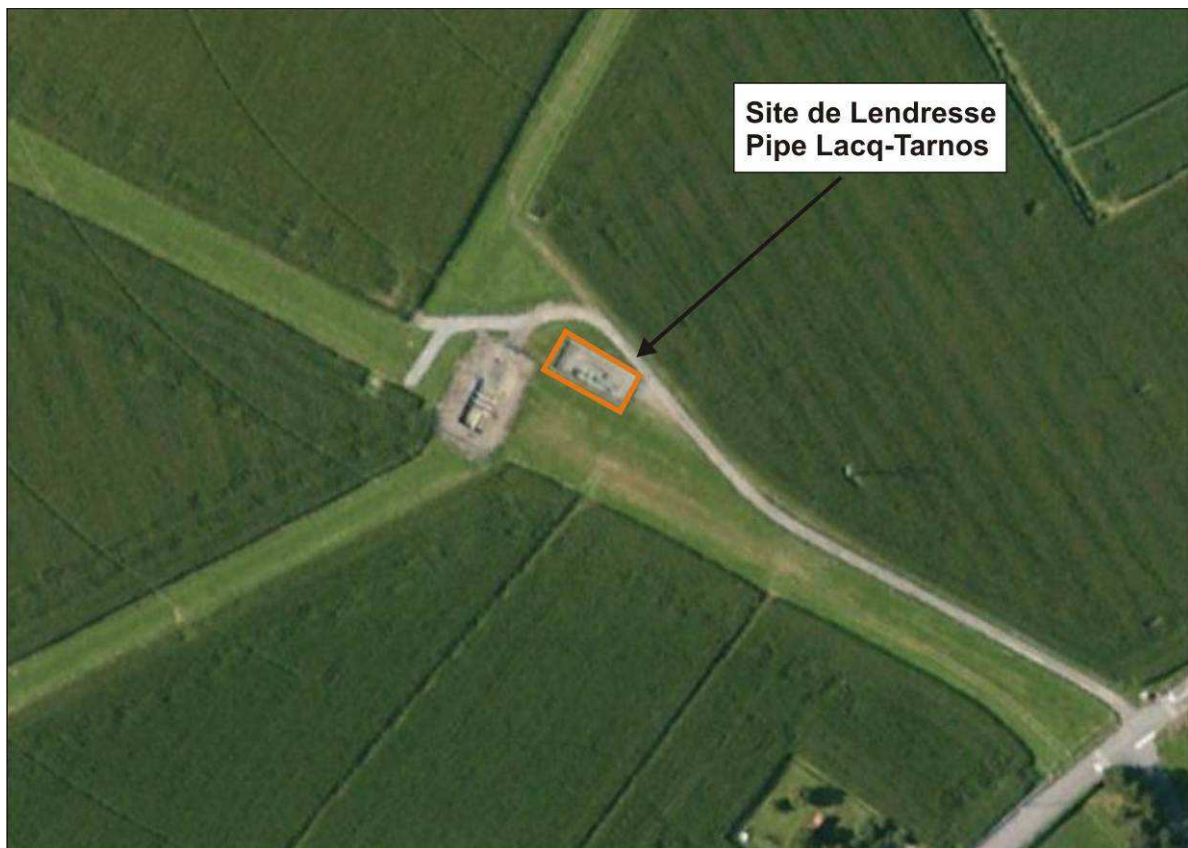
FIGURE 22 : VUE AERIENNE DU SITE DE LENDRESSE (AVANT DEMANTELEMENT)
